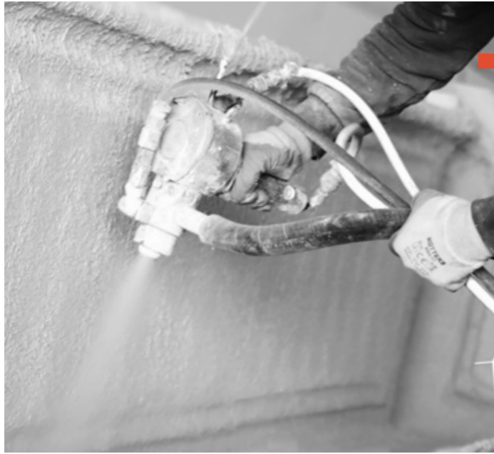
GFRG spray production
