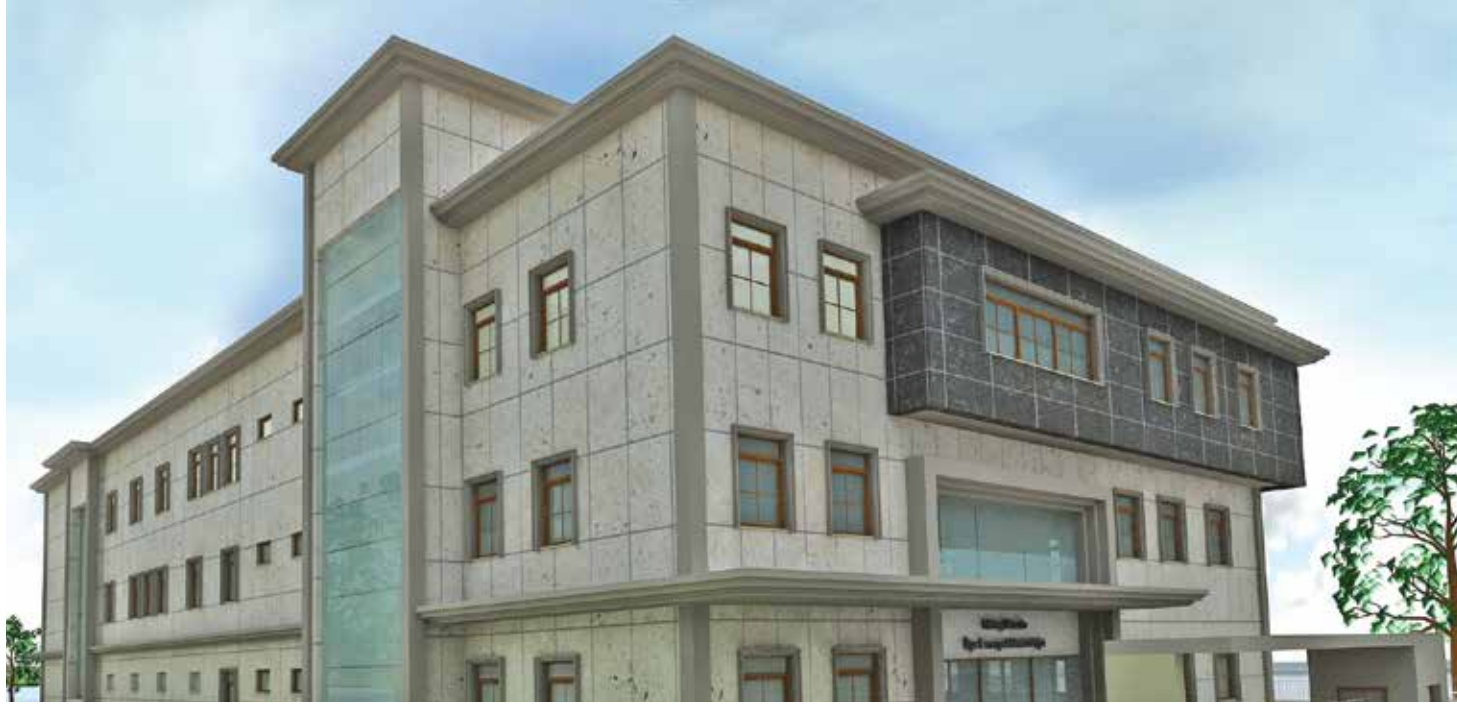
■ KURLU İLÇE EMNİYET MÜDÜRLÜĞÜ / ANTAKYA
